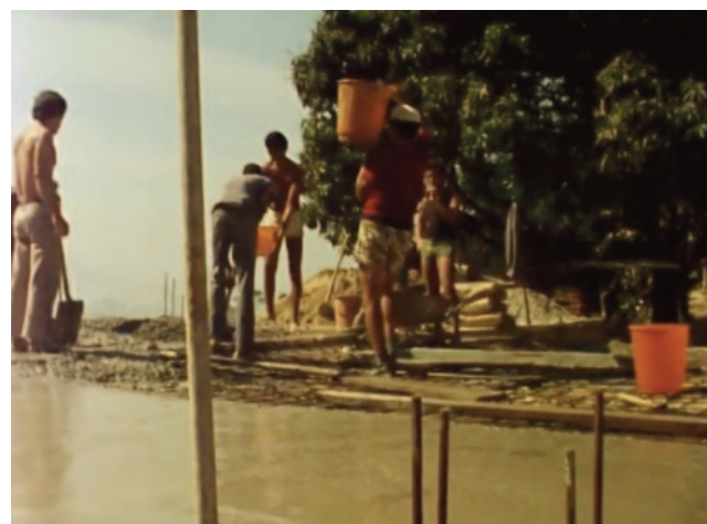
Em cima da Terra, Embaixo do Céu, still
