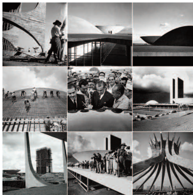
Galeria Brasília em Construção
